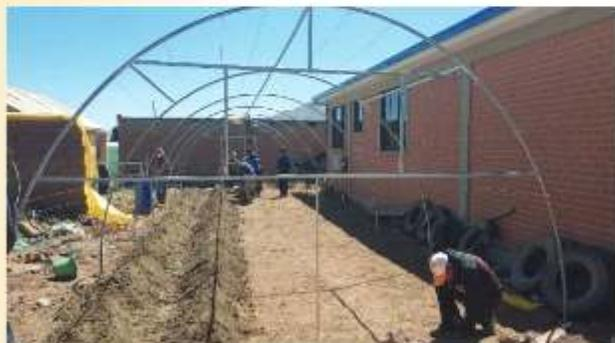
Al momento de la construcción de los camellones se recomienda que la tierra preparada debe estar húmedo para una construcción estable, y en el momento del armado hacia arriba se va reduciendo a 35 cm. La construcción de los camellones se recomienda que debe ser realizado antes de colocar la cubierta en el invernadero.
