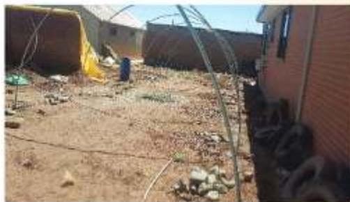
El tubo curvado tiene una medida de 9 metros lineales. De cada pÓrtico de 1" y la altura principal del invernadero es de 2 m con 50 cm.
