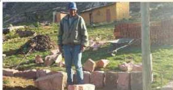
Dejamos secar el cimientto y luego proceder el pircado con ladrillo y con mezcla preparada de cemento de arena y agua. La altura de un lado largo se debe levantar de 6 filas con ladrillo de 6 huecos y el otro lado posterior de 4 filas, el lado ancho y su paralela levantar la pared formando en gradas para igualar a los lados largos.
