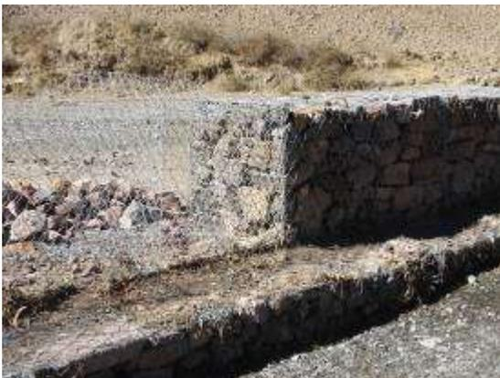
Las presas de gavión están construidas en cajones de malla que se rellenan de piedra o rocas, formando barreras resistentes. Las presas detienen la velocidad del agua y alcanzan a captar tierra y sedimentos, que de otra manera se perderían en los grandes ríos.
